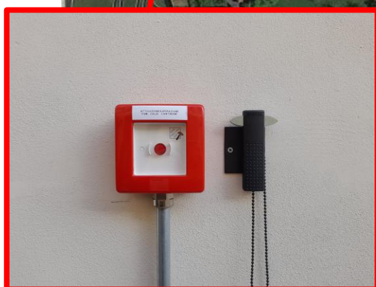
Pulsante di attivazione aspirazione dei fumi caldi
